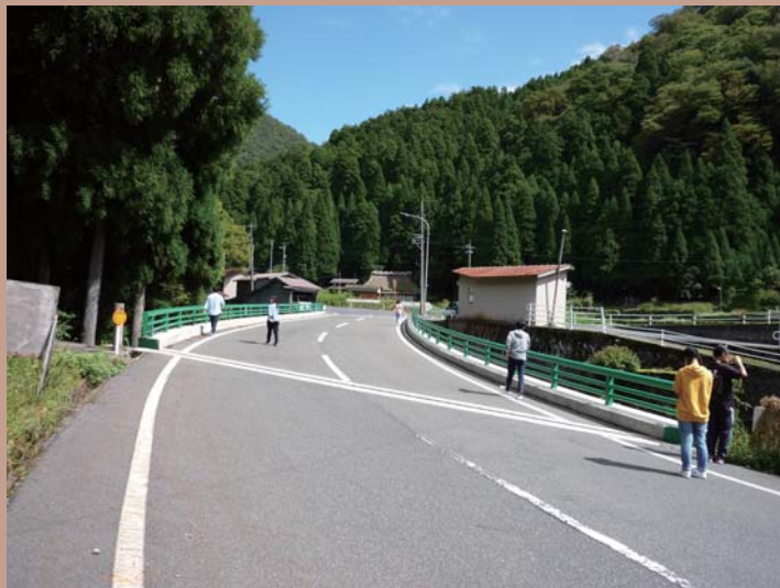
来見野橋の現地調査
